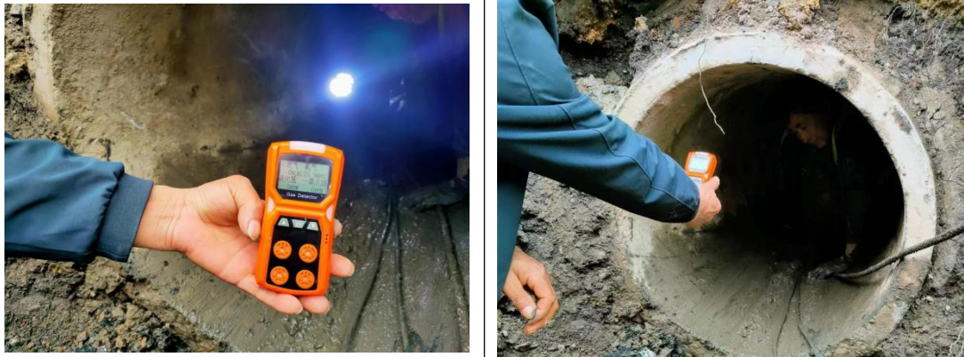
管道内气体检测
