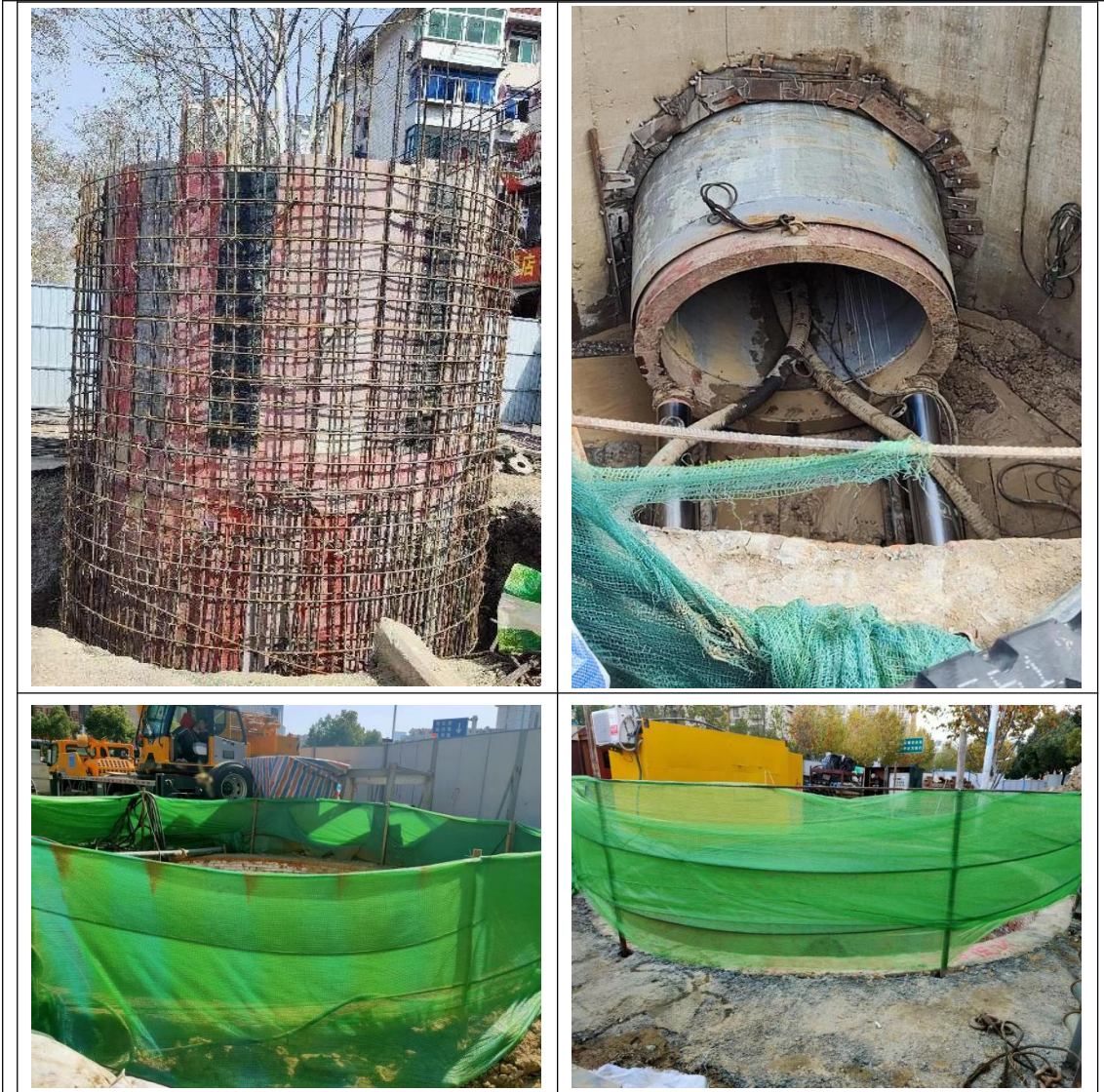
顶管穿越施工现场图
