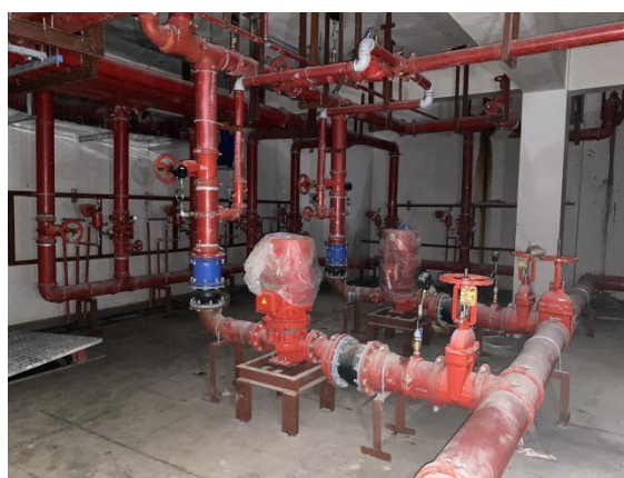
设备安装减振基座
